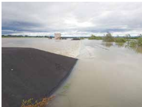
図-28 台風19号での遊水地への水の引込み
