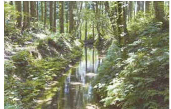
大崎地域上流部の山間水路
